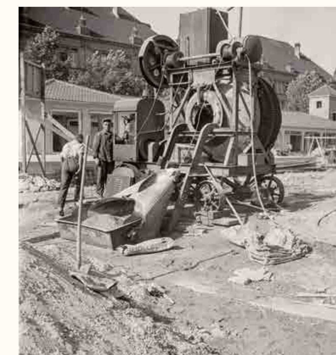
Während der Bauarbeiten
