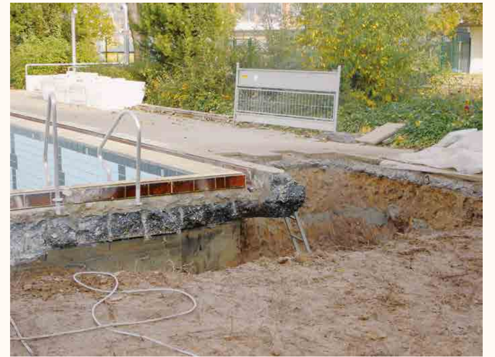
Der freigelegte alte Beckenkopf.
