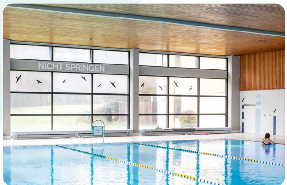
In unseren Hallenbädern, hier im Köpfelbad in Heidelberg-Ziegelhausen, sorgen Neutralisationsanlagen für eine Einhaltung der Einleitungswerte für Abwasser.
